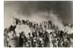
Max Alpert: «Construcción del Gran canal de Fergana (Uzbekistán)», s. f. [¿1939?]
